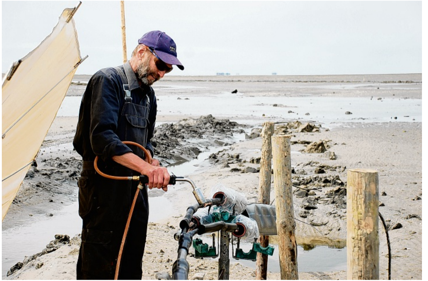
Bevor die Flut kommt, muss Peter Kröger die Kabel verbunden haben.
